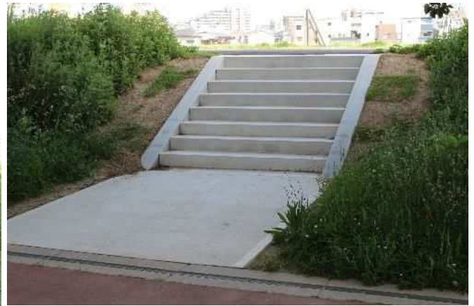
④堤防踏み荒らし個所に新設された階段
