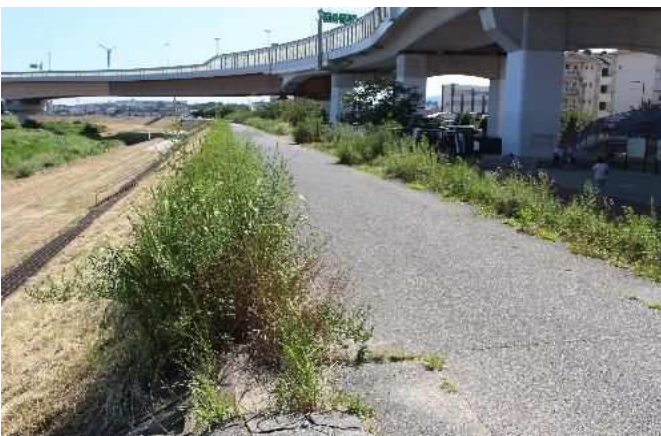
⑤天端通路の状況
