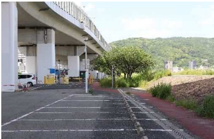
①全景（下流側より）
