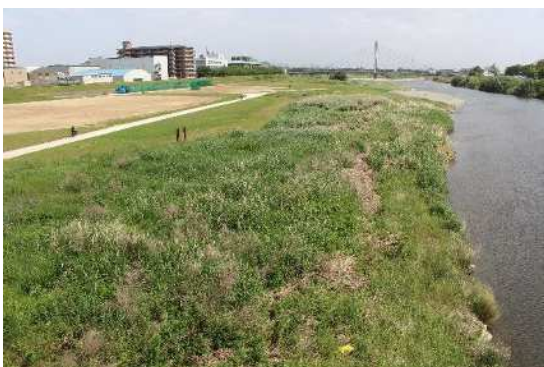
⑦河岸側の状況
