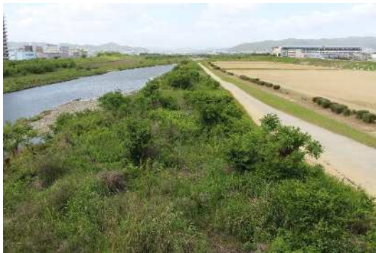
⑤河岸側の状況
