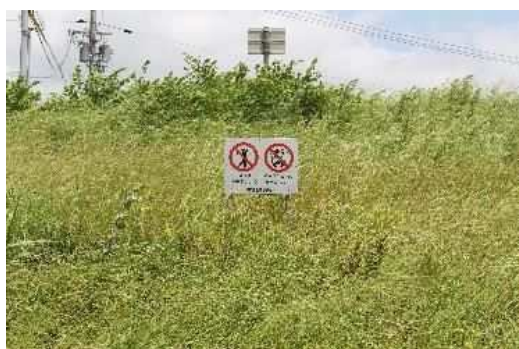
⑦利用ルールの看板の状況
