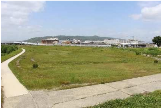
①全景(下流側より)
