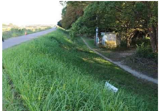
④坂路付近より下流方向を望む
