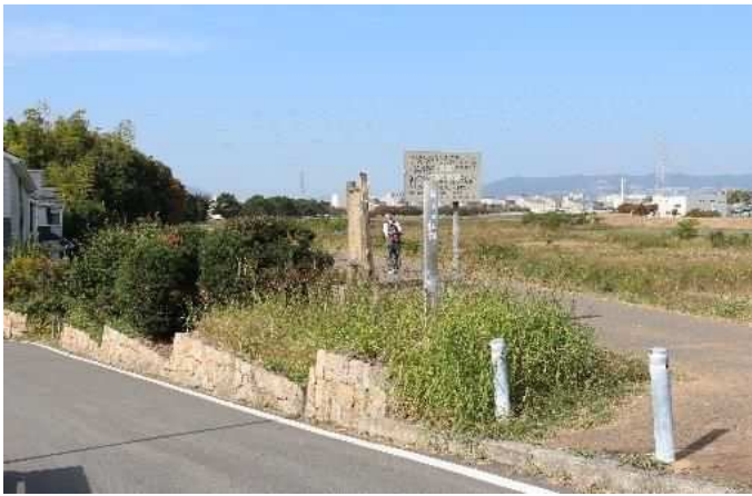
①全景（下流側より上流側を望む）
