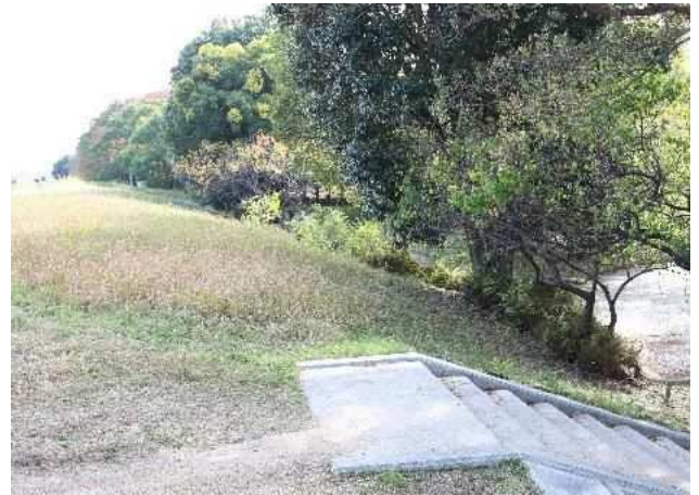
②全景（上流側より下流側を望む）
