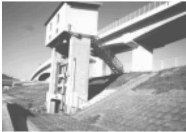
神田排水樋門 平成13年11月 池田市神田地先
