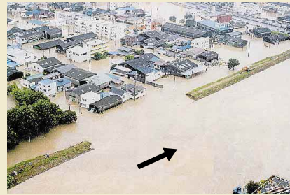
平成12年9月 新川(名古屋市)の破堤による浸水
