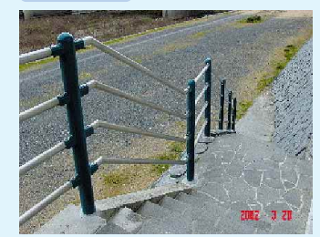
手すり付階段工
