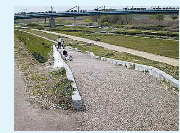
緩傾斜坂路 (占用・伊丹市)
