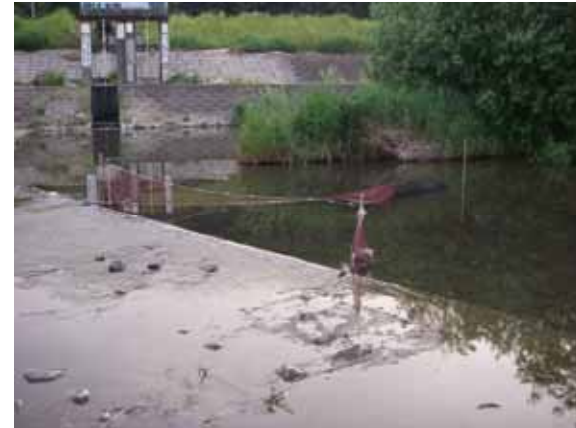
大井井堰右岸越流部
