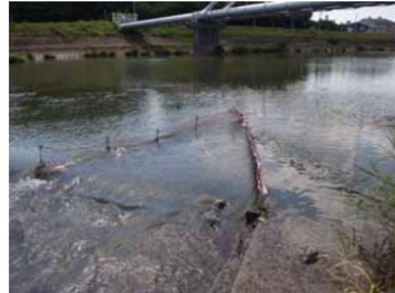
大井井堰魚道部
