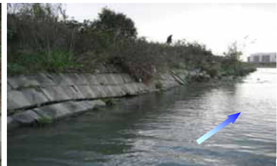
全景(上流方向撮影) 低水護岸 連節ブロック下部 ズレ落ち隙間あり
