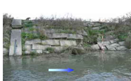
連節ブロックの乱れ状況 連節ブロックのずり落ち及び乱れ ズレ30cm 奥行き50cm
