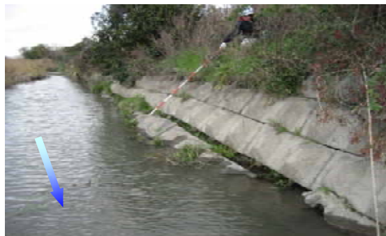
全景(上流方向撮影) 低水護岸 連節ブロック下部 ズレ落ち隙間あり
