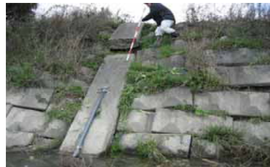
小口止めコンクリートの断裂状況 隙間50cm 段差45cm
