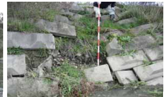
連節ブロックの乱れ状況 連節ブロックのずり落ち及び乱れ ズレ30cm 奥行き50cm
