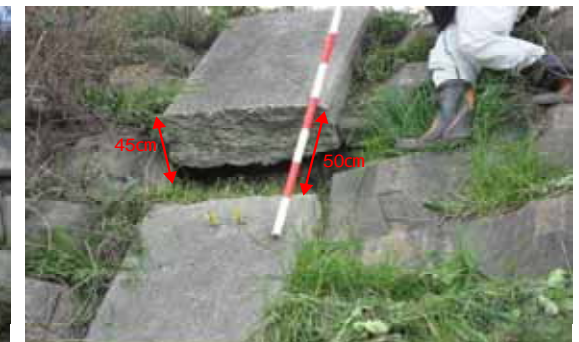
小口止めコンクリートの断裂状況 隙間50cm 段差45cm
