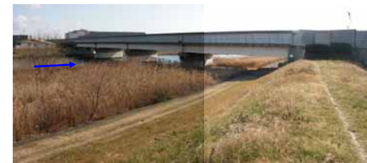
右岸より撮影 (平成23年2月13日撮影)
