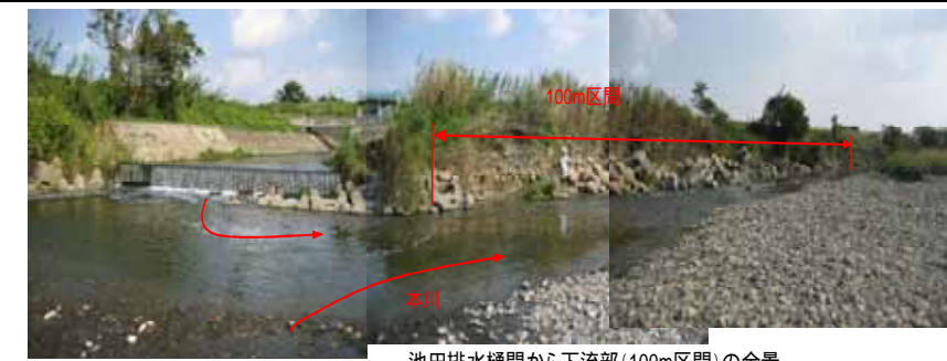
池田排水樋門から下流部(100m区間)の全景
