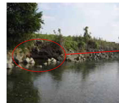
下流部の状況
