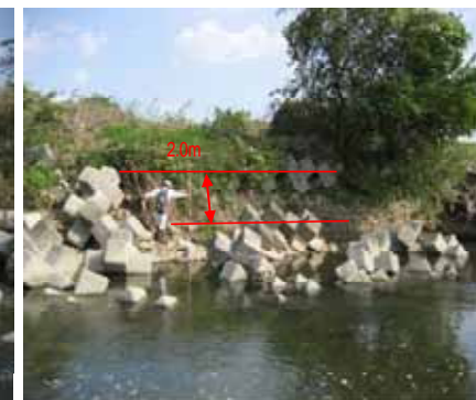
下流部の状況
