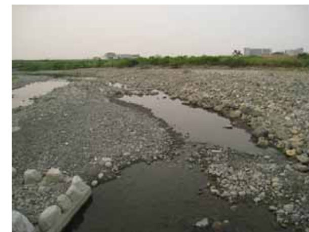
魚道下流端付近 非常に浅く、魚道への到達は困難である。
