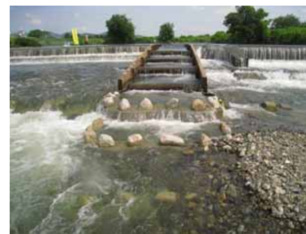
魚道内 流量がある程度多いと魚道に水が流れる。
