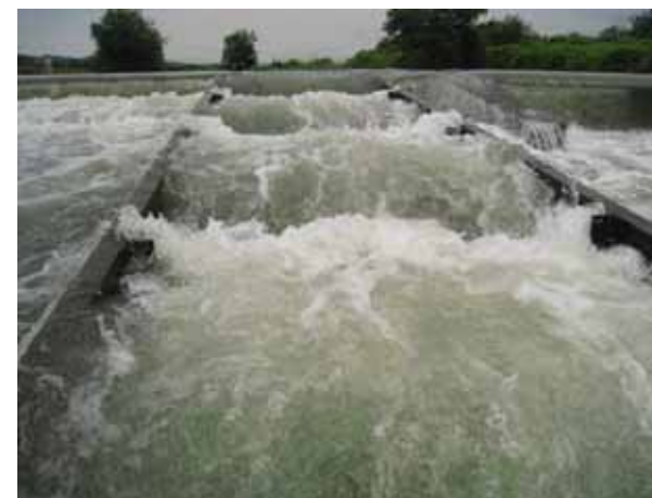
魚道内 増水時は魚道への流量は非常に多い。
