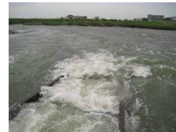
魚道下流端付近 流速が早く遡上が困難であると考えられる。
