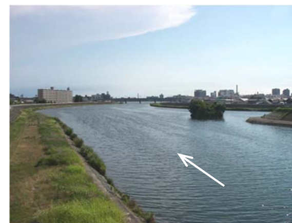
施工前[戸ノ内橋下流 0.6k 付近] (H24.7)
