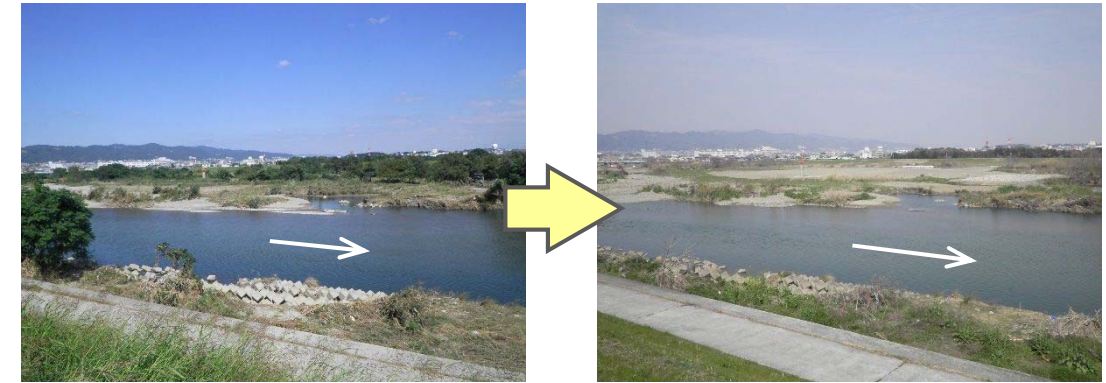
施工前[猪名川 7.2k 付近] (H25.10)
