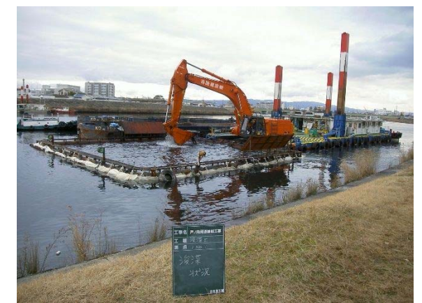
施工中[汚濁防止対策実施状況] (H25.1)
