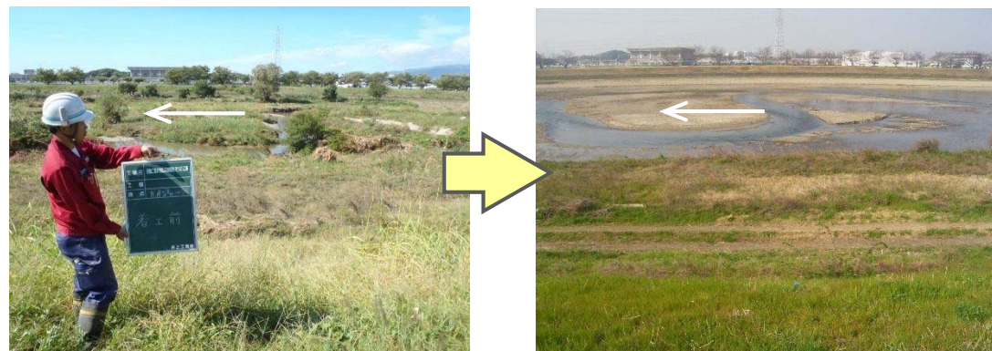
施工前[猪名川 5.2k 付近左岸] (H25.10)
