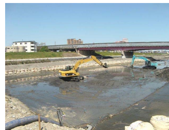
施工中[名神猪名川橋下流 1.4k 付近] (H25.5)
