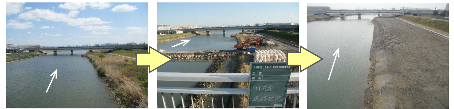
施工前[東園田橋下流 0.6k 付近] (H25.4)
