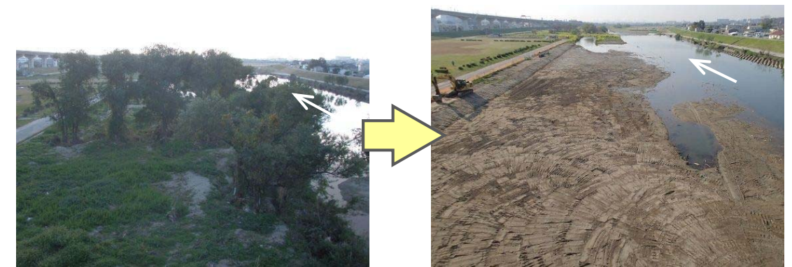
施工前[中国道下流 9.0k 付近] (H25.11)
