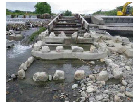
写真1.3.4 三ヶ井井堰 魚道 (H26.5.23 軍行橋水位0.33: 平水～豊水)
