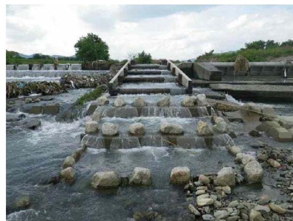
写真1.1.2 簡易魚道の全景 (H26.5.22)
