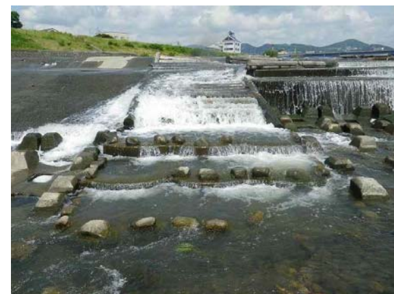
写真1.2.2 簡易魚道(右岸側)の全景 (H26.6.9)
