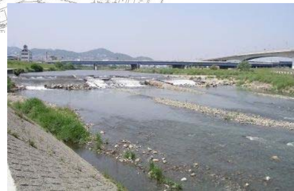
写真1.2.1 高木井堰の全景 (H26.5.13)
