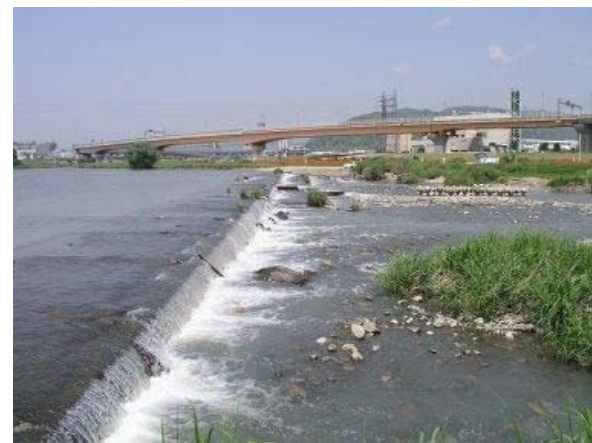
写真1.3.1 久代北台井堰の全景 (H26.5.13)
