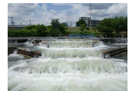
写真1.3.3 久代北台堰 魚道 (H26.6.9 軍行橋水位0.24: 低水～平水)
