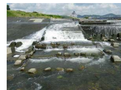
写真1.3.1 高木井堰 右岸魚道 (H26.6.9 軍行橋水位0.24: 低水～平水)
