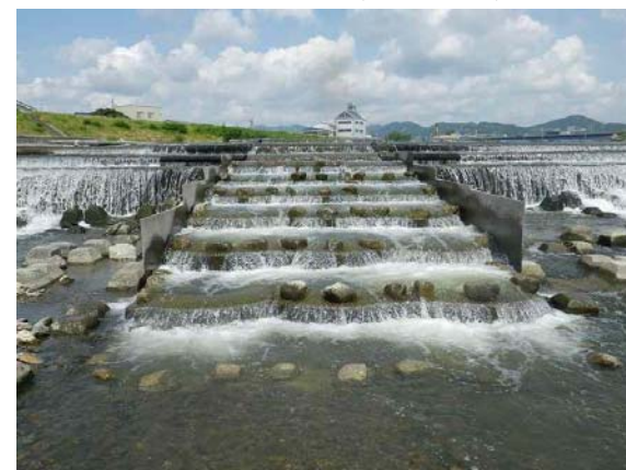
写真1.2.3 簡易魚道(中央部)の全景 (H26.5.22)
