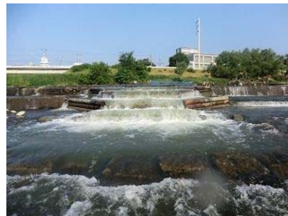
写真1.3.2 簡易魚道の全景 (H26.6.14)
