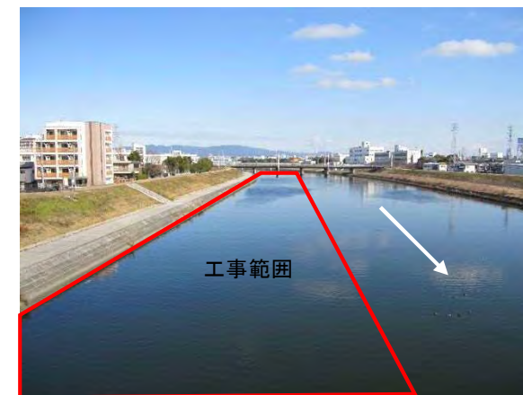
写真①戸ノ内橋から上流を望む (H28.1)
