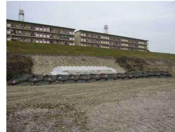
写真①藻川左岸 3.4k 付近 (H28.1)
