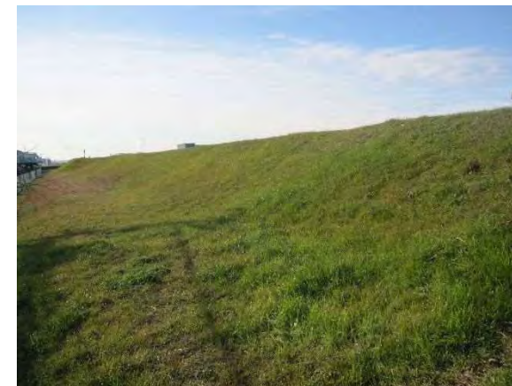
写真①猪名川左岸 7.2k 付近 法尻 (H28.1)
