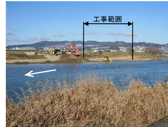
写真①猪名川左岸 8.2k 付近より上流を望む (H28. 1)
