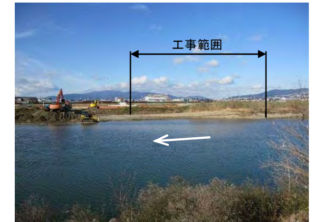
写真②猪名川左岸 8.3k 付近より右岸を望む (H28. 1)
