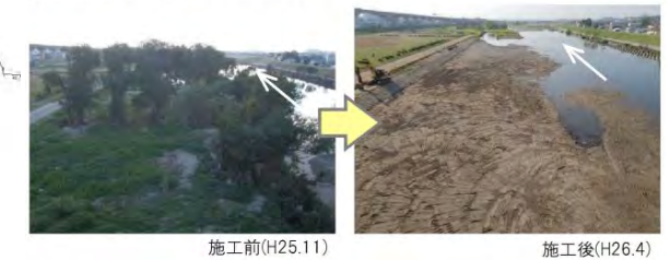
【施工前後写真(猪名川 9.0k 付近)】
