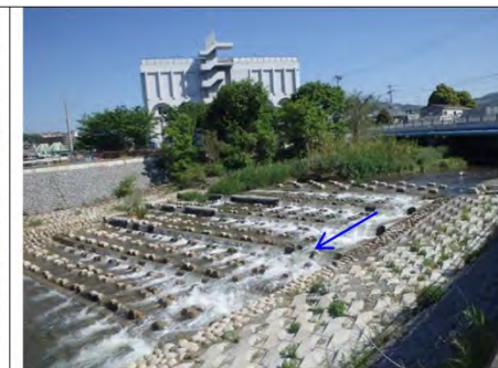
魚道を下流側から望む
