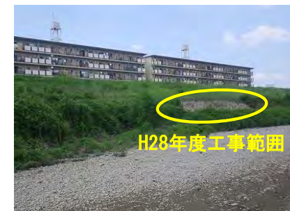
工事箇所の状況(平成28年8月撮影)
