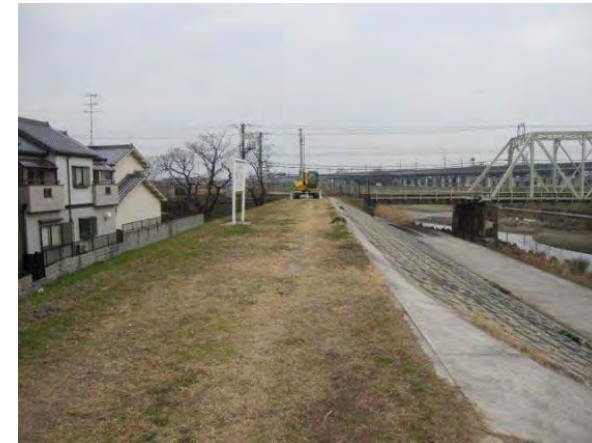
写真①藻川左岸1.8k付近(H28.1)
