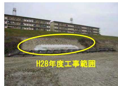
工事箇所の状況(平成28年1月撮影)
