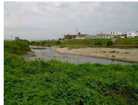
写真①藻川左岸3.4k付近堤防より(H28.8)
