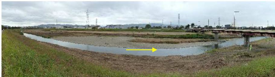
現地状況 猪名川4.6k右岸 (令和3年10月26日撮影)
