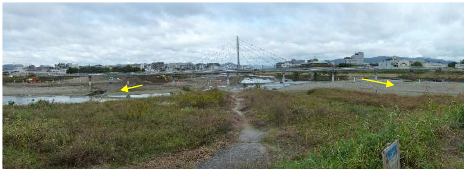
現地状況① 分派地点より上流(令和3年10月26日撮影)
