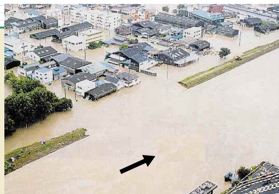
新川(名古屋市)の破堤による浸水(平成12年9月)
