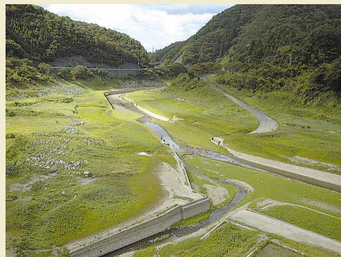
一庫ダムに流入する田尻川の状況(平成14年8月21日)
