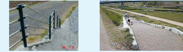
手すり付階段工
