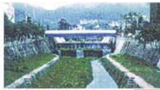
床止め(落差工)
