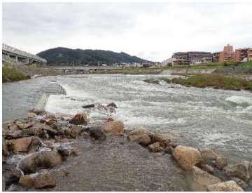
当日の現地状況(増水)
