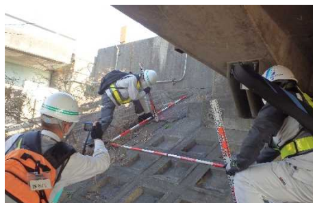
▲護岸のひび割れを点検
