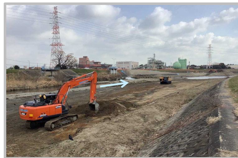
写真① 掘削状況
