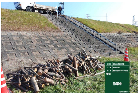
樹木伐採施工状況
