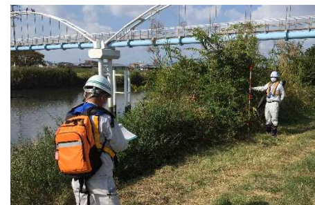
▲樹木の繁茂状況を点検
