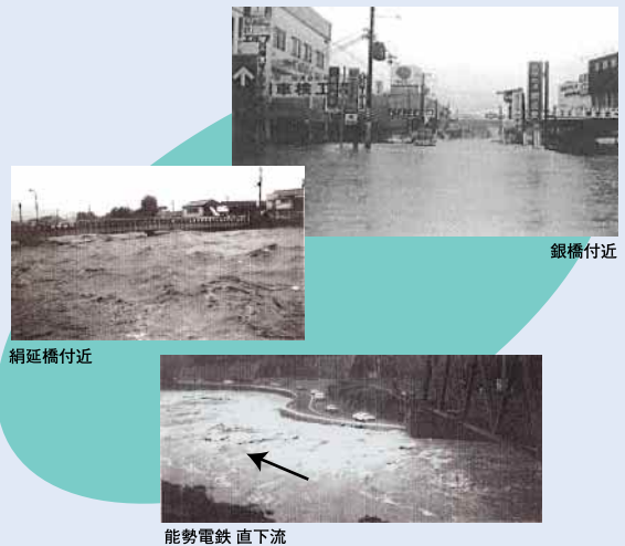
■昭和58年9月洪水被害状況写真
