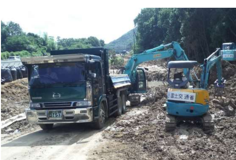
土砂の除去と道路啓開作業
