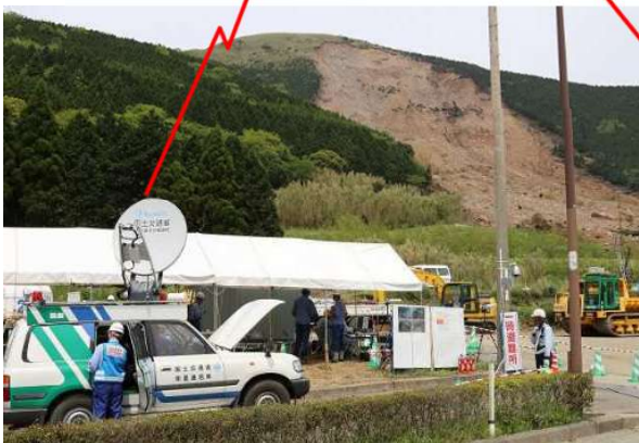
衛星通信車による 被災箇所の監視
