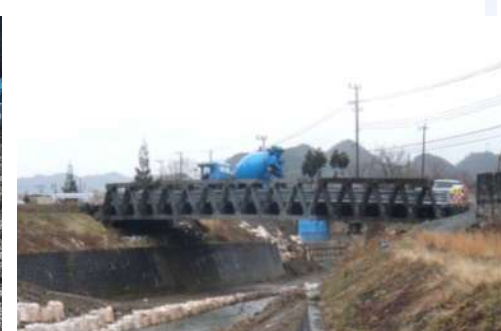
応急組立橋による交通路の確保
