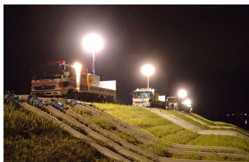
排水ポンプ車による緊急排水作業
