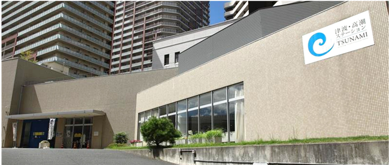
「津波・高潮ステーション」外観
