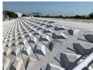
堤防裏法尻の補強【東園田】施工前後
