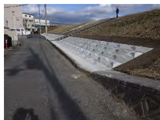
堤防裏法尻の補強0.5km【東園田】施工前後
