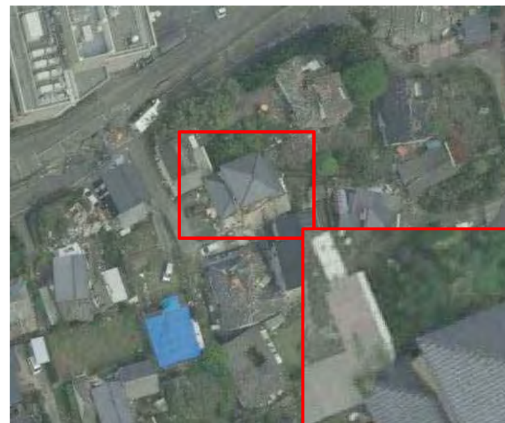
平成28年熊本地震（益城町役場周辺）
