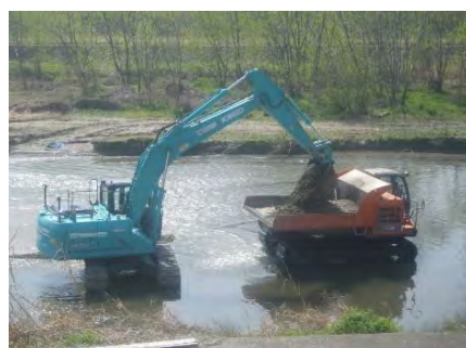
流下能力対策【利倉～岩屋】施工中
