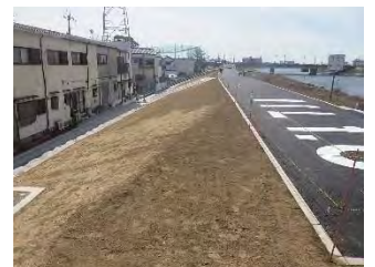
堤防裏法尻の補強0.1km【戸ノ内】施工前後
