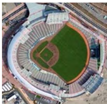
大州雨水貯留池 上部利用
