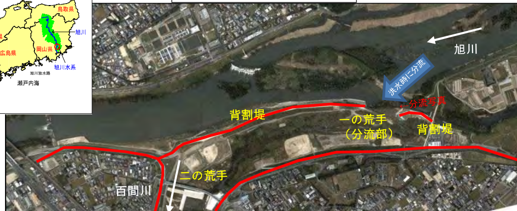
旭川放水路(百間川) 分流部
