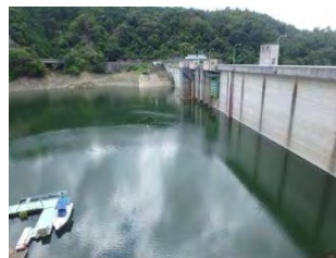
洪水貯留開始前の貯水池 (7月2日10時頃)
