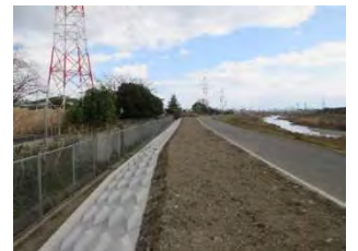
堤防裏法尻の補強0.1km【原田西】施工前後
