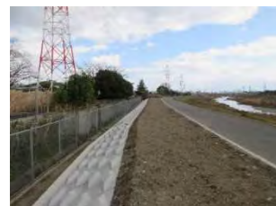
堤防裏法尻の補強0.1km【原田西】施工前後
