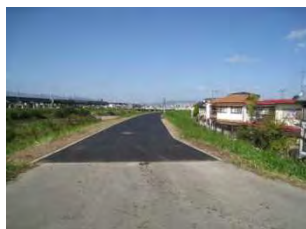
堤防天端の保護1.3km【東園田】施工前後
