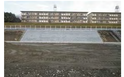
侵食・洗掘対策 0.2km【田能】施工前後
