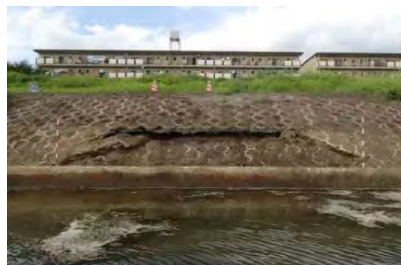
侵食・洗掘対策 0.2km【田能】施工前後
