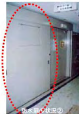
防水扉の状況②
