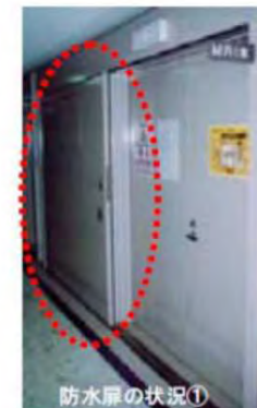
防水扉の状況①
