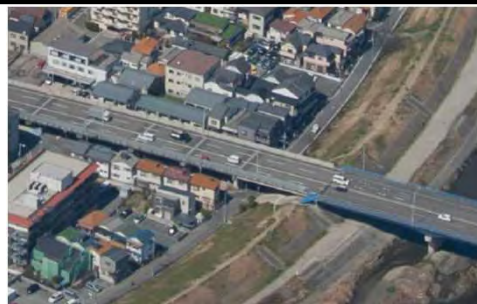
堤防天端から新南園橋に アクセスできない
