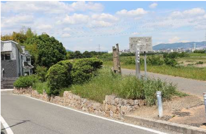
①全景（下流側より上流側を望む）
