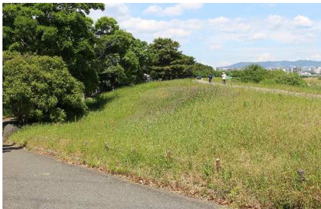
③坂路付近より上流方向を望む
