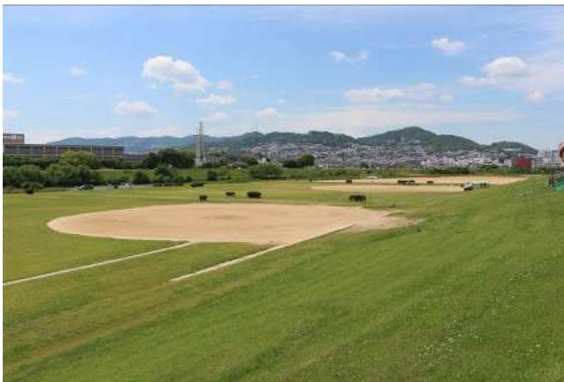
① 上流側全景
