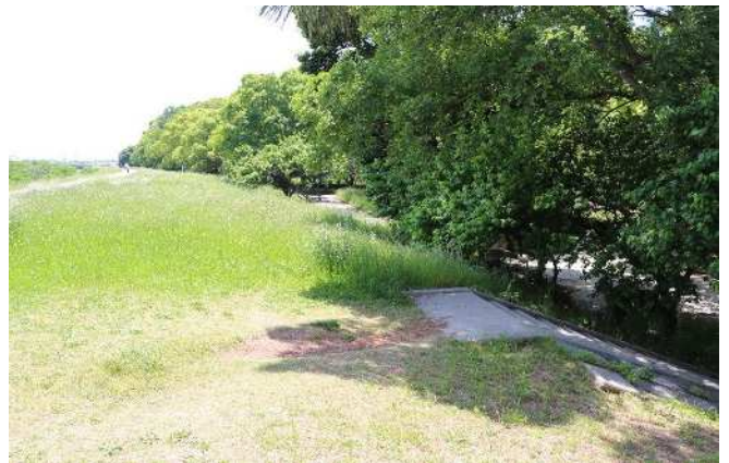
②全景（上流側より下流側を望む）
