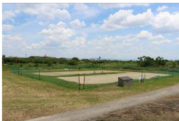
②全景（上流側から下流を望む）
