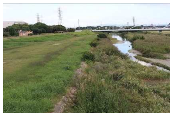
⑧ 低水河岸部の状況
