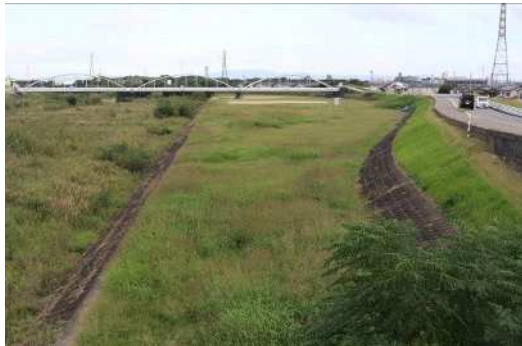
① 右岸上流側全景
