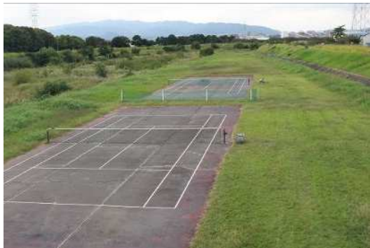
③ 左岸上流側全景
