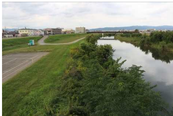
④ 低水河岸部の状況
