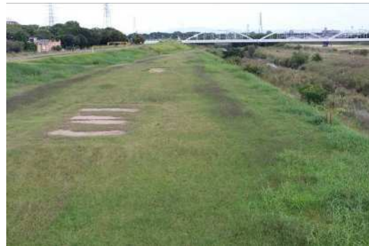
④ 左岸下流側全景
