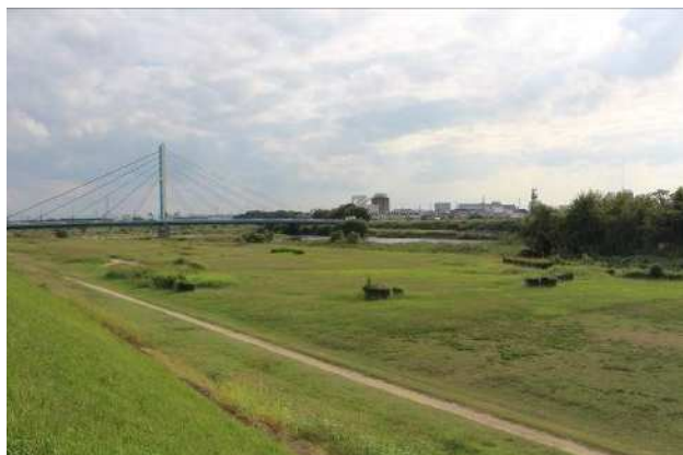
① 上流側全景
