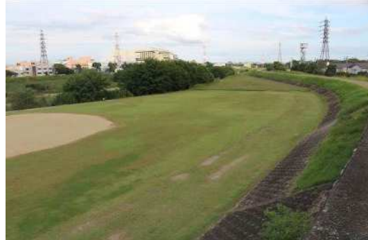
② 右岸下流側全景
