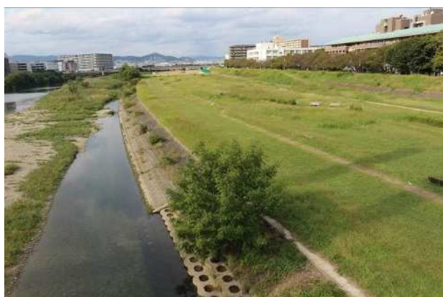
⑤ 低水河岸部の状況（上流側）
