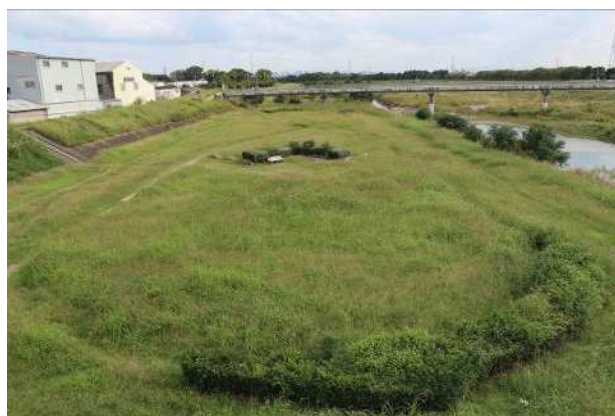
② 下流側全景
