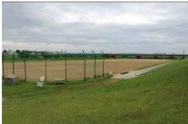
①全景(上流側より)
