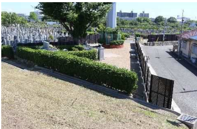
①全景（上流側より）
