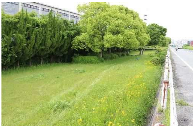
②公園内全景（下流側より）
