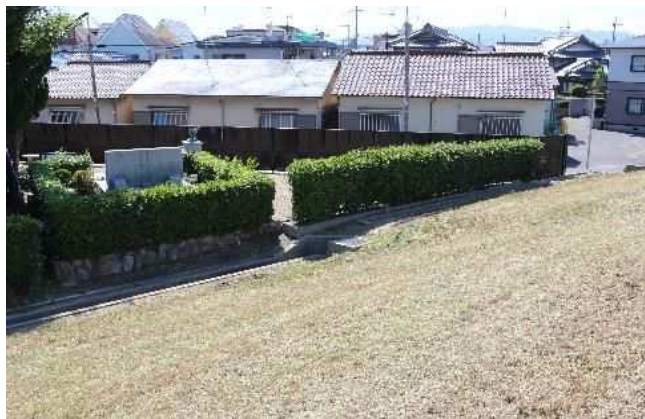
②全景（下流側より）
