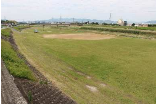
① 右岸上流側全景
