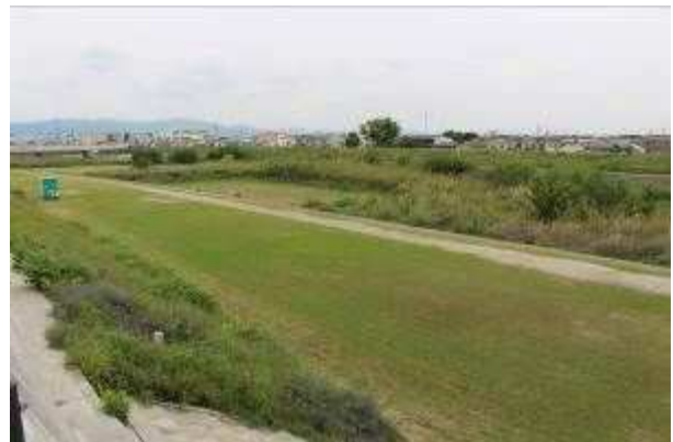
② 上流側全景と不法占用グラウンドの状況
