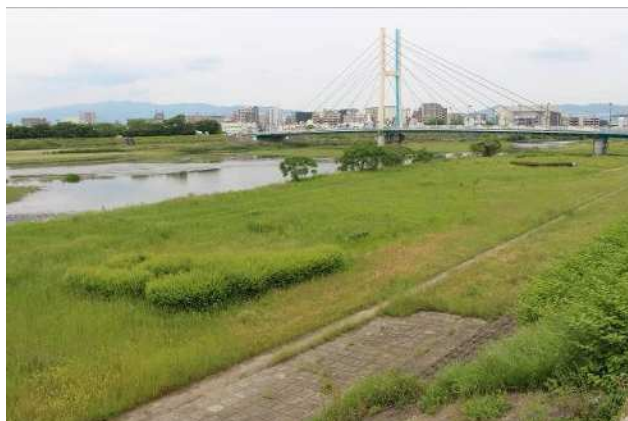
②下流側全景
