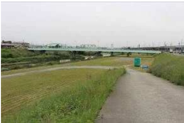
① 下流側全景(テニスコート)
