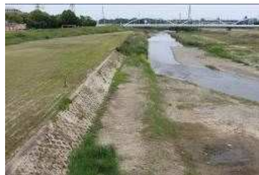
⑧左岸側の低水河岸部の状況
