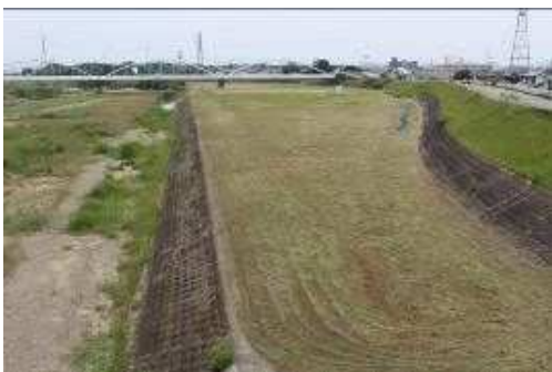
⑦右岸側の低水河岸部の状況
