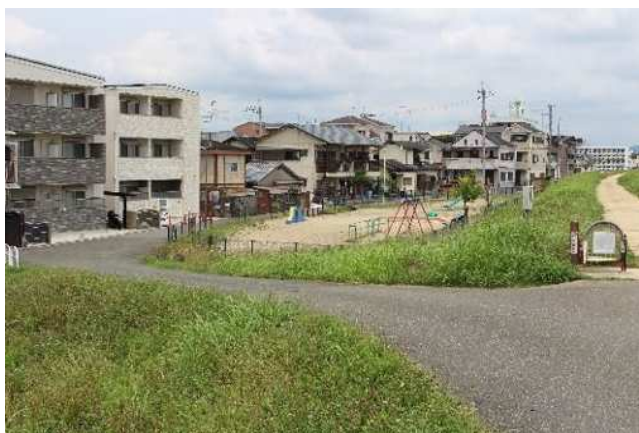
①通路も含めた占用地の全景（下流側より）
