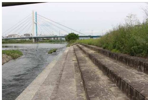
⑥低水河岸部の状況(下流側)
