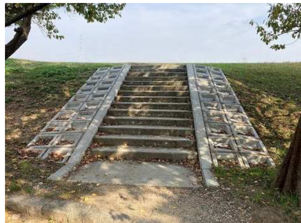
⑥新設された階段の状況
