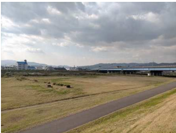
下流端付近(南多目的広場)の状況
