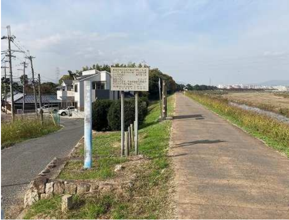
①下流端より上流方向を望む
