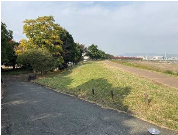
③坂路付近より上流方向を望む
