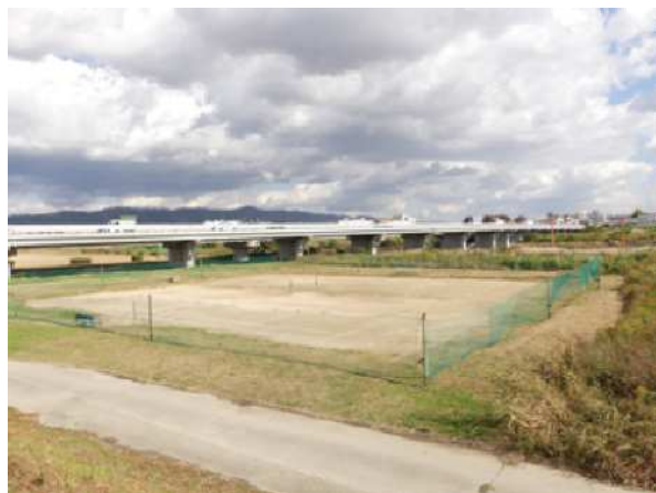
全景(下流端付近から上流を望む)
