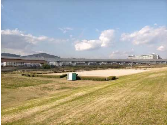
上流端付近(北多目的広場)の状況
