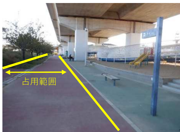
③下流部（阪急橋下流より下流側を望む）
