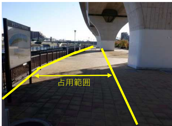
①上流部（中橋付近より下流側を望む）
