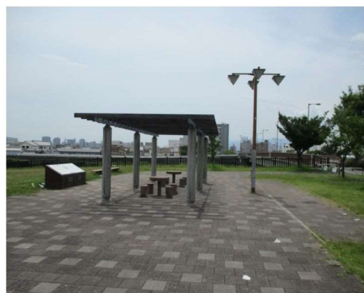
⑥パーゴラ、テーブルセットの状況
