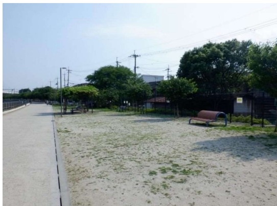
①全景（上流側より）
