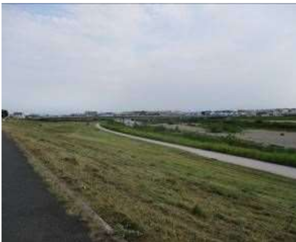
② 全景(上流から下流を望む)
