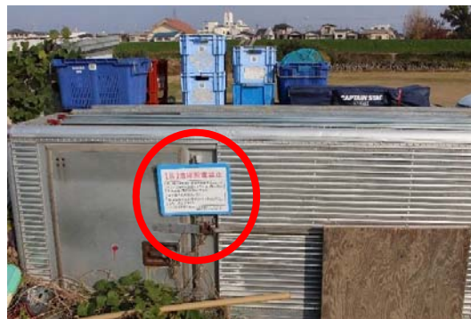
禁止看板設置状況
