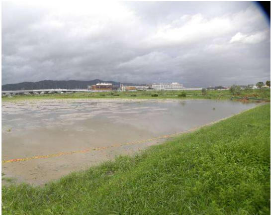
⑧グラウンド被災状況(平成 30 年 7 月 7 豪雨)
