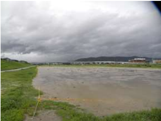
⑦グラウンド被災状況(平成 30 年 7 月 7 豪雨)
