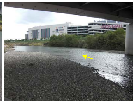
桑津橋直下の礫河原 (H25.9.24)
