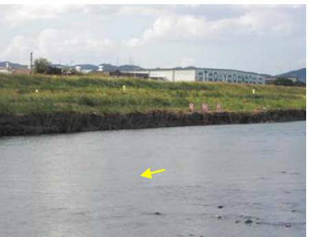
出水後 (H25.9.24) の試験施工地
