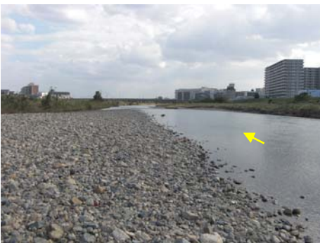
出水後 (H25.9.24) の試験施工地対岸
