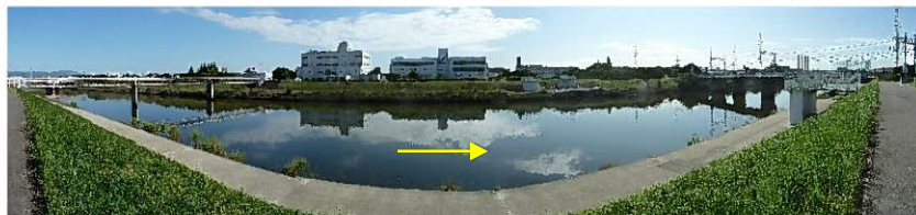
現地状況① 猪名川1.1k付近（令和5年10月12日撮影）
