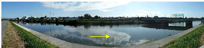
現地状況② 猪名川0.7k付近（令和5年10月12日撮影）
