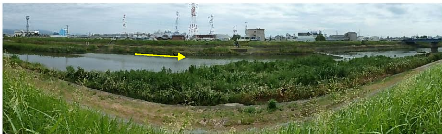
現地状況① 2.6k付近 (令和5年8月18日撮影)
