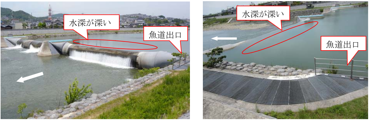
図 3.3.2 加茂井堰の状況 (H27.5.22)
