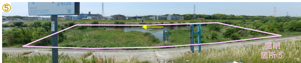
現地状況 猪名川3.0k左岸 (令和7年5月20日撮影: 工事前)
