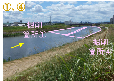
現地状況 名神高速道路猪名川橋上流 (令和5年8月5日撮影: 工事前)
