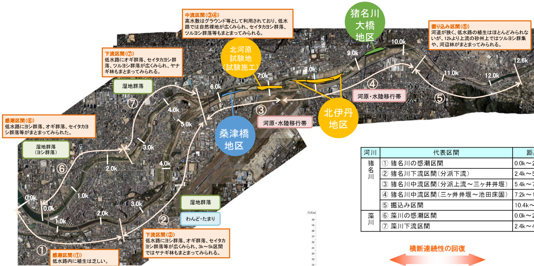
猪名川直轄管理区間の自然再生箇所と各代表区間と重要な環境 (代表的な河川景観)
