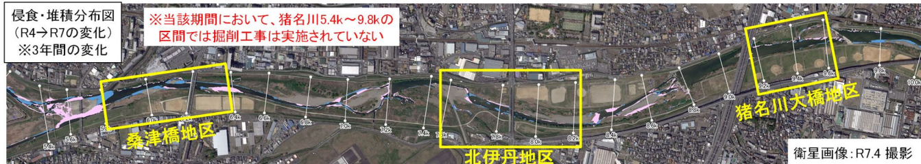
図 6.2.4 直轄管理区間における侵食・堆積分布の変化(河原環境が重要な区間)
