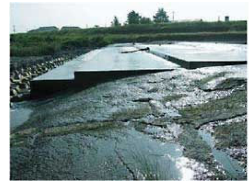
魚類の遡上・降下の阻害となっている横断工作物の例(高木井堰)
